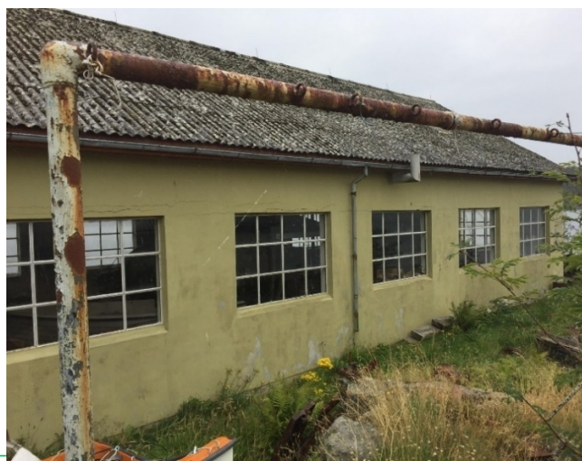
Nedlagt mekanisk industri på Hegraneset
