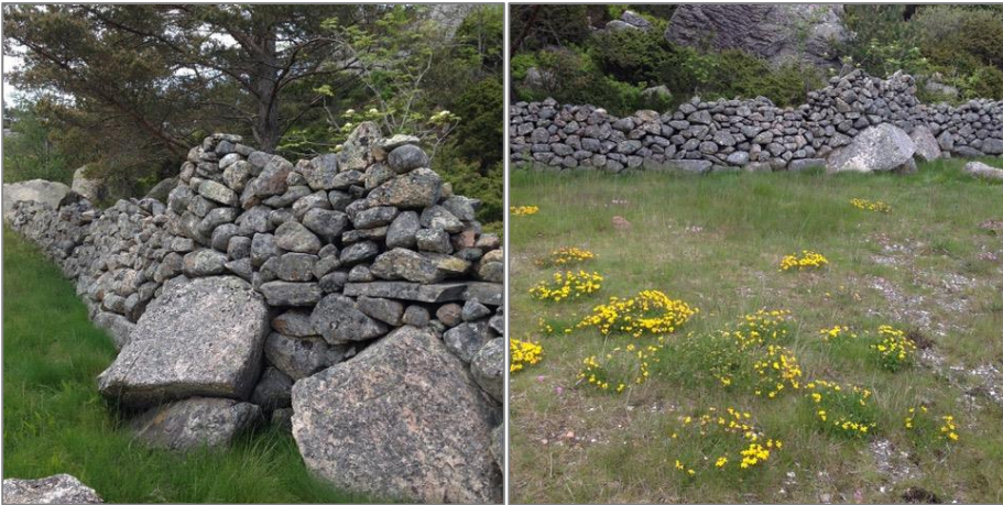
Figur 13 Bilde av ny opparbeida steingard innanfor planområdet.
