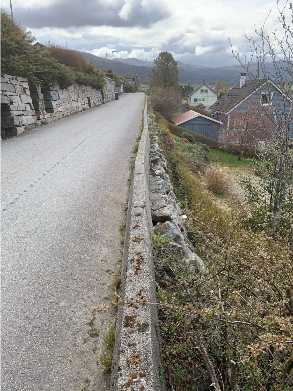
Foto av eksisterande situasjon:
