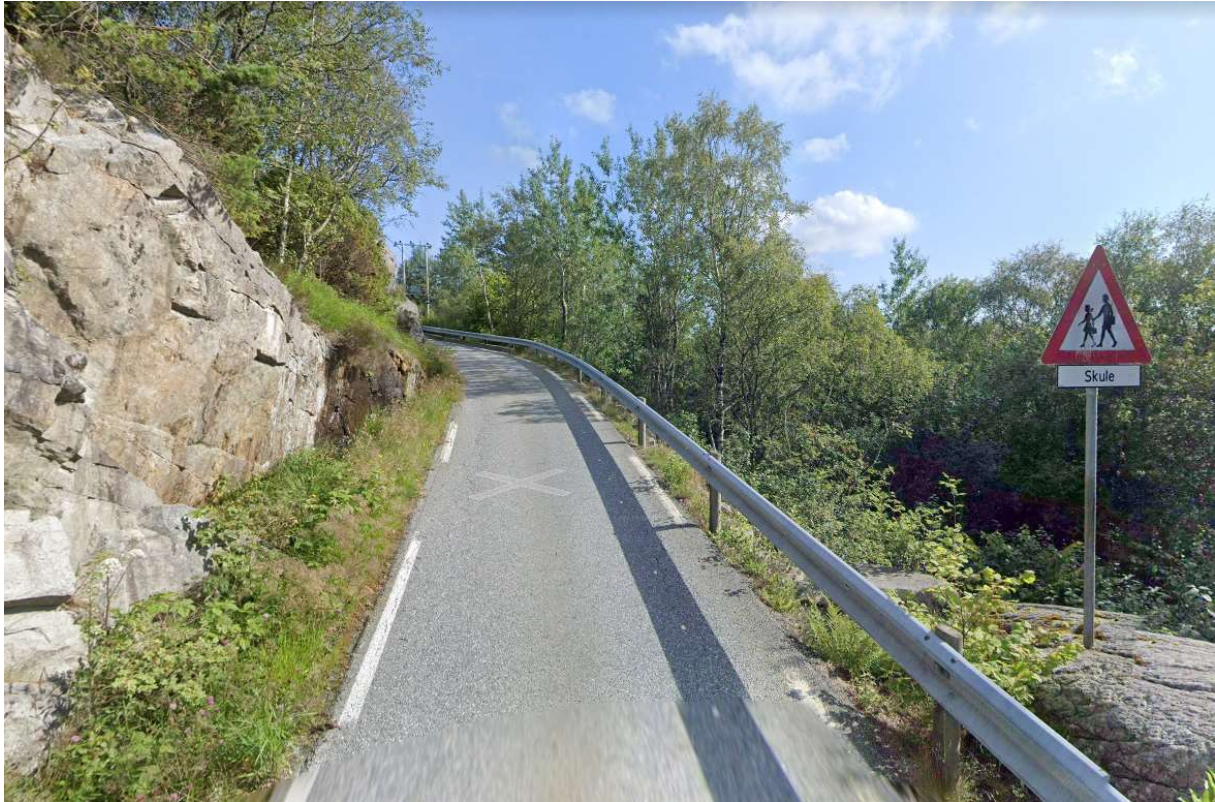
Tiltak pos.4: Sprenging for sikt. Fartsgrense 60 km/t. Areal ca. 40 m 2 . 4 høgdekoter (snitt 2,5?)
