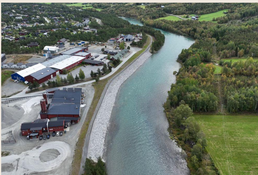
Figur 16 Flomsikring ved Bismo, Skjåk kommune. Foto: Teknisk ukeblad
