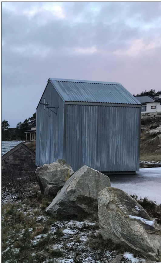
Figur 7: Pumpestasjon på Rossnes
