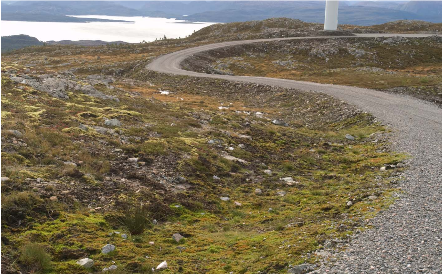
En variert, naturlig vegetasjonsmosaikk i veiskråningene gjør at inngrepene glir inn i terrenget rundt og derved blir mindre iøynefallende
