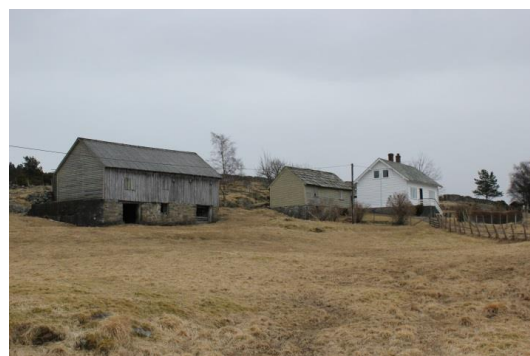
Våningshus, uthus og løe, 58.6. Gardsmiljø.
